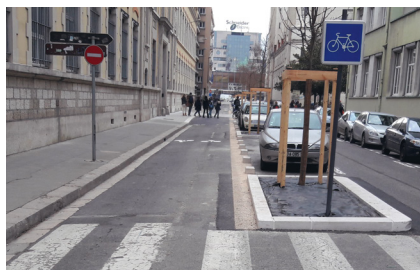
▲ Grenoble, rue Casimir Brenier : pour éviter les débordements, des petits blocs de béton ont été ajoutés pour compléter la résine beige qui délimite l'espace tampon. (Paris en Selle)
