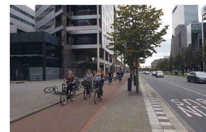
▲ Rotterdam (Pays-Bas), Weena : la piste de 2,50 m de large permet de doubler un autre vélo ou de rouler à deux de front confortablement, malgré une bordure de trottoir non chanfreinée et un caniveau pavé. (Paris en Selle)
