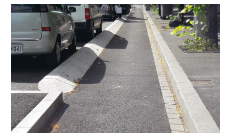
▲ Arcueil, avenue Laplace : le séparateur de 70 cm est chanfreiné, ce qui réduit l'effet paroi, qui reste néanmoins présent côté trottoir. (Paris en Selle)
