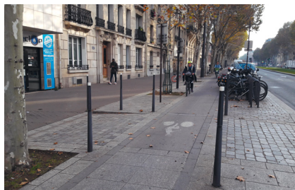
▲ Paris 14°, boulevard Jourdan : les potelets protègent la piste au droit d'une entrée charretière avec un espacement (1,95 m) plus large que la piste. Ils sont en métal donc résistants dans le temps mais dangereux en cas de collision. (Paris en Selle)
