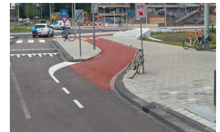
▲ Amsterdam (Pays-Bas), Kon. Wilhelminaplein : le basculement de la chaussée vers la piste se fait naturellement, sans franchissement de bordure de trottoir ou de fil d'eau, avec des girations douces. (Google Street View)
