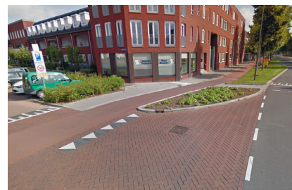
▲ Bois-le-Duc ('s Hertogenbosch, Pays-Bas), Muntelbolwerk : quand l'espace le permet, décaler la piste favorise des croisements orthogonaux avec les voitures tout en libérant un espace de stockage pour les vélos qui veulent tourner à gauche. (Google Street View)
