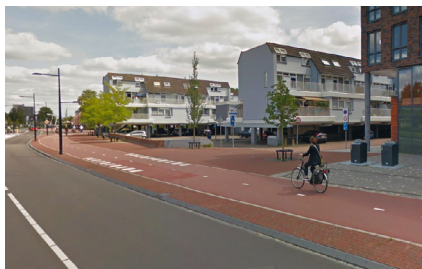
▲ Assen (Pays-Bas), Het Kanaal : un espace tampon d'au moins 1,00 m assure un meilleur confort sur une piste bidirectionnelle où des vélos longent une chaussée avec des véhicules motorisés qui circulent en sens inverse. Cet espace permet aussi d'implanter du mobilier et de la signalisation, et d'aménager un rampant pour les accès motorisés transversaux. (Google Street View)
