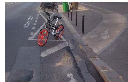
▲ Paris 12 e , boulevard Diderot : le basculement de la piste sur chaussée vers la piste sur trottoir croise la bordure et le fil d'eau avec pas moins de quatre revêtements différents, et des girations serrées. (Paris en Selle)
