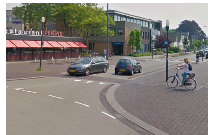
▲ Drachten (Pays-Bas), Laweiplein : un giratoire sans signalisation verticale, ni piste cyclable, et une différenciation minimale entre le trottoir et la chaussée. Souvent donné en exemple, ce giratoire pousse surtout le vélos à rouler avec les piétons. (Google Street View)
