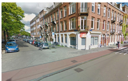
▲ Amsterdam (Pays-Bas), Admiraal de Ruijterweg : le trottoir et la piste se prolongent avec leurs bordures simplement mises au même niveau que la chaussée (pas de rampant). (Google Street View)
