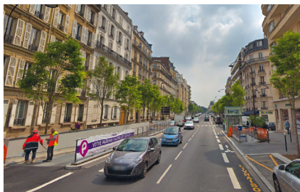
▲ Neuilly-sur-Seine, avenue de Madrid : l'implantation des nouveaux alignements d'arbres et des accès au parking souterrain flambant neuf entrave durablement l'évolution future de la rue. (Google Street View)
