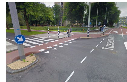
▲ Amsterdam (Pays-Bas), Tussen Meer : la bande cyclable (en haut à droite sur la photo) se transforme en piste dans l'intersection. Les vélos attendent le vert 10 m en aval des voitures. La piste est décalée, ce qui libère un espace de stockage pour les tourne-à-droite motorisés qui croisent la piste quasiment à angle droit. (Google Street View)
