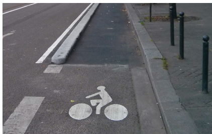
▲ Paris 13 e , quai François Mauriac : le caniveau en asphalté diminue fortement la largeur circulaire de la bande en enrobé avec un seuil de raccord inconfortable. Au second plan, la piste et le caniveau sont au contraire d'un seul tenant avec de l'enrobé. (Paris en Selle)
