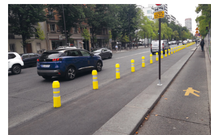
▲ Paris 13°, avenue d'Italie : pendant les travaux du centre commercial, un nouveau cheminement cyclable sécurisé est créé à la place du stationnement. (Paris en Selle)
