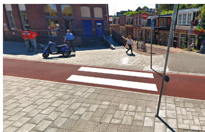
▲ Amsterdam (Pays-Bas), Admiraal de Ruijterweg : la traversée piétonne de la piste vers l'arrêt de tramway est matérialisée par des bandes blanches et des bandes d'éveil de vigilance pour guider les malvoyants. (Google Street View)
