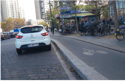
▲ Paris 13°, place d'Italie : la piste se situe à niveau intermédiaire, avec un séparateur de 15 cm de haut côté chaussée, dissuasif envers le stationnement sauvage. (Paris en Selle)
