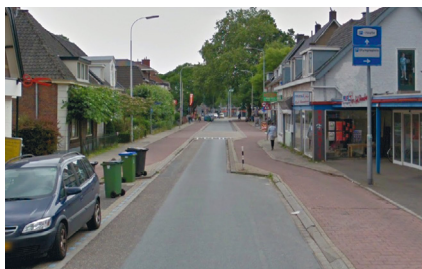
▲ Wageningen (Pays-Bas), Churchillweg : la rue se resserre et la décision a été prise de conserver la piste cyclable en réduisant la chaussée, avec une écluse pour le trafic de transit motorisé. (Google Street View)
