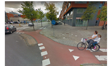
▲ Amsterdam (Pays-Bas), Postjeweg : l'unité du domaine de voirie incite à rester sur la piste plutôt que de couper tout droit : girations douces, revêtement continu sans bordure ni fil d'eau... (Google Street View)
