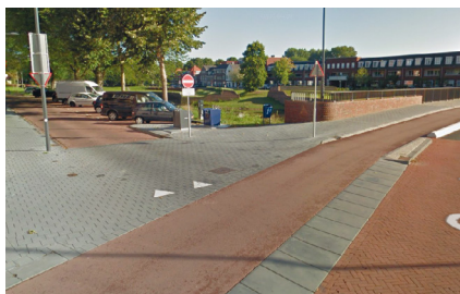
▲ Bois-le-Duc ('s Hertogenbosch, Pays-Bas), Graafseweg : la piste est au niveau de la chaussée en section courante avec un séparateur étroit. Elle monte doucement au niveau du trottoir et se décale légèrement pour l'insertion du rampant. (Google Street View)
