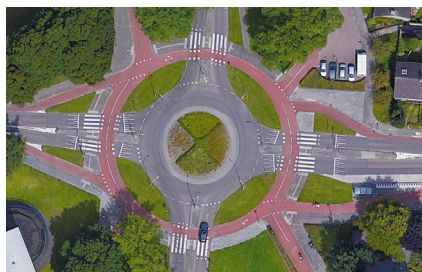
▲ Amersfoort (Pays-Bas), Paladijnenweg / Holkerweg : un giratoire avec un anneau cyclable prioritaire unidirectionnel pour le franchissement est-ouest et bidirectionnel pour le franchissement nord-sud afin d'assurer une bonne continuité des itinéraires cyclables. Les franchissements bidirectionnels disposent d'un plateau traversant. (Google Maps)
