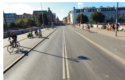
▲ Copenhague (Danemark), Nørrebrogade / Dronning Louises Bro : l'axe le plus circulé à vélo de la ville a fait l'objet d'un élargissement de ses deux pistes unidirectionnelles à 4,00 m afin de faire face à des pics de fréquentation de plus de 35 000 vélos par jour. (Google Street View)
