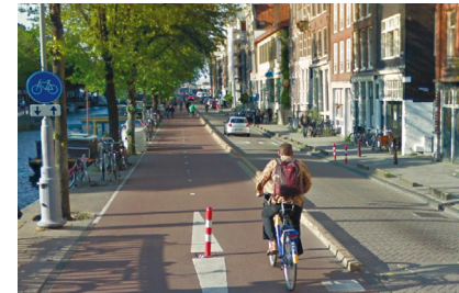
▲ Amsterdam (Pays-Bas), Geldersekeade : le potelet au centre de la piste bidirectionnelle est bien signalé mais reste dangereux en cas de collision. (Google Street View)
