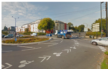
▲ Nantes, Bourgeoionière / Guy Mollet : le marquage vélo au centre de l'anneau motorisé favorise un positionnement moins accidentogène, mais ne permet pas de diminuer le stress engendré par la cohabitation avec un trafic automobile dense. (Google Street View)
