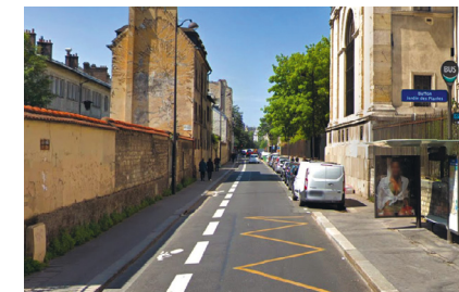
▲ Paris 5 e , rue Buffon : la bande à contresens évite un long détour. Par rapport à une piste (impliquant la suppression du stationnement et des élargissements de trottoir), elle permet d'avoir une chaussée compatible avec la voie échelle pompiers qui limite le risque de dépassement rasant dans le sens général (7 000 véhicules/jour). Le stationnement illicite est rare dans cette rue. (Google Street View)
