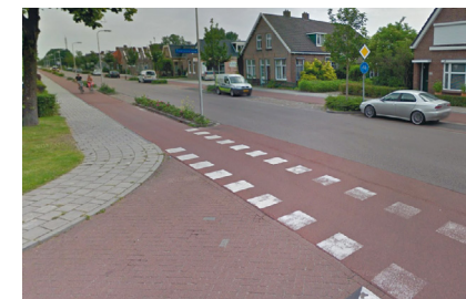
▲ Assen (Pays-Bas), Groningerstraat : la piste conserve son revêtement rouge avec un marquage blanc, ce qui lui offre une priorité visuelle acceptable malgré le faible espace tampon. (Google Street View)
