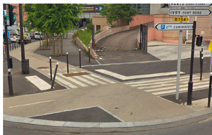
▲ Ivry-sur-Seine, quai Jean Compagnon : les girations sont tracées à la règle avec des angles droits inadaptés à la physique d'un vélo. (Google Street View)
