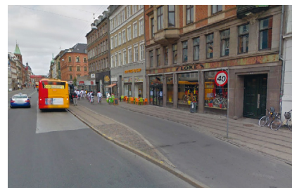
▲ Copenhague (Danemark), Nørrebrogade : la piste cyclable surélevée ne dispose pas d'espace tampon en section courante, mais elle est légèrement déviée au droit de l'arrêt de bus pour permettre la création d'un quai qu'elle contourne. (Google Street View)
