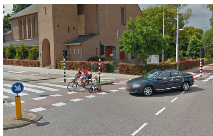
▲ Amsterdam (Pays-Bas), Hugo de Vrieslaan : l'espace tampon créé par l'îlot de coin et le dévoiement de la piste vers l'extérieur renforcent la sécurité. (Google Street View)
