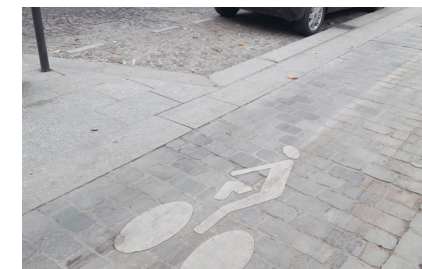
▲ Paris 13 e , rue Croulebarbe : des pavés sciés sont utilisés pour la piste, plutôt que les pavés parisiens classiques inconfortables qui jalonnent la chaussée. (Paris en Selle)
