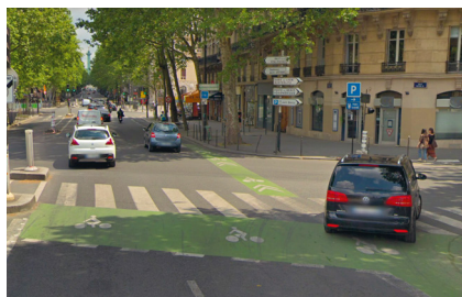
▲ Paris 4 e , pont de Sully : un sas vélo (coloré) qui remplace abusivement une simple ligne d'arrêt reculée. Aucun vélo ne va se positionner dans le sas devant le trafic motorisé puisque le tourne-à-gauche n'est pas possible à ce carrefour. (Google Street View)
