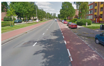
▲ Assen (Pays-Bas), Thorbeckelaan : une bande cyclable en enrobé rouge de 2,10 m de large (dont 0,10 m de marquage) avec une surlargeur de 0,70 cm en pavés le long des espaces de stationnement motorisé. Elle reste moins sécurisante que la piste cyclable dans l'autre sens. (Google Street View)
